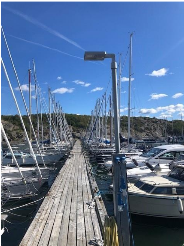
Göteborgs stad Grefab – Installerad 2018
